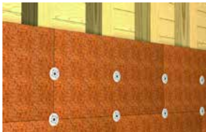
Befestigung von Holzweichfaserplatten auf Vollholz
